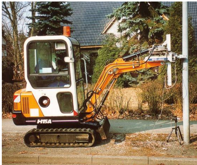
Figuur 1: Roch-Services opstelling
