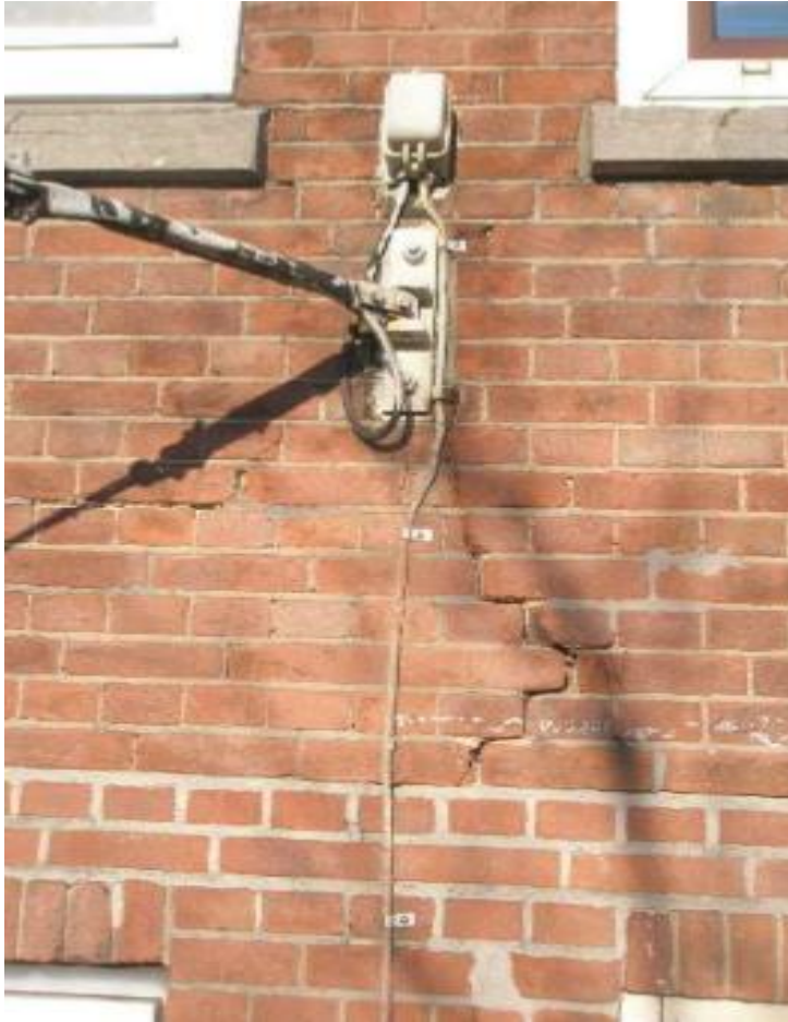
Scheur vanuit kozijn
