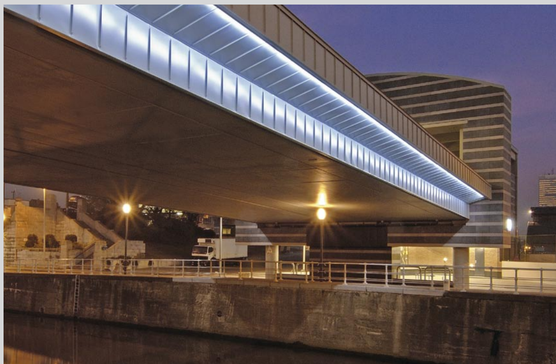
De metrobrug die over het kanaal van Charleroi naar het Delacroix-station in Brussel loopt, wordt verlicht met 92 TiltLED van 2000 mm, voorzien van witte HP-leds met een opening van 120°. Dit was een noodzakelijke keuze aangezien de lampen boven het kanaal moeilijk bereikbaar zijn voor onderhoud.
