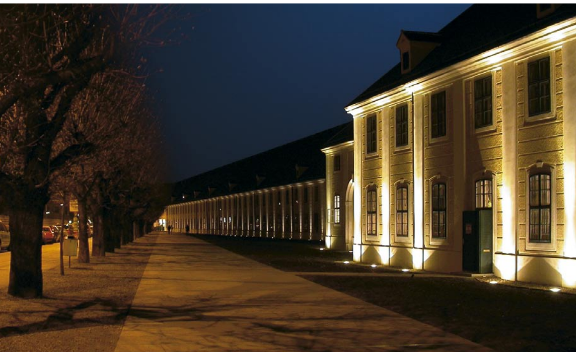
Het paleis van Schönbrunn, het Weense zomerverblijf van de Habsburgers, wordt verlicht door 50 Noctis Maxi-schijnwerpers uitgerust met 6 witte HP-leds.
